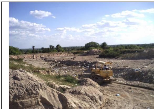
Foto 18: Lixão de Olho d'Água das Flores durante o processo de recobrimento dos resíduos.
