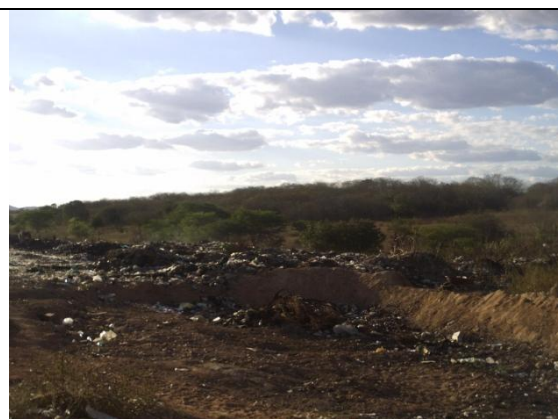
Foto 11: Obra de aplainamento da área para aterramento de lixo.
