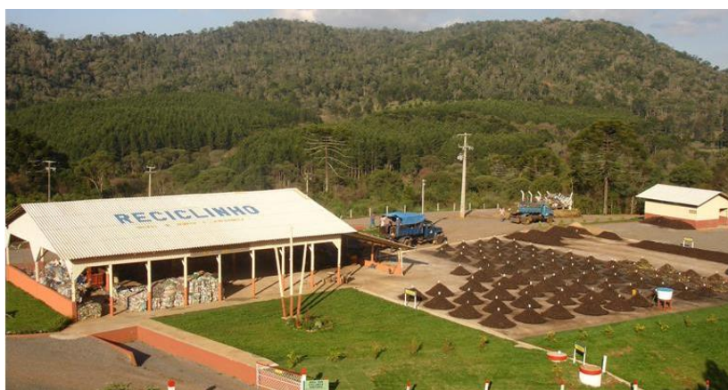
Figura 5.13 – Unidade de compostagem.
