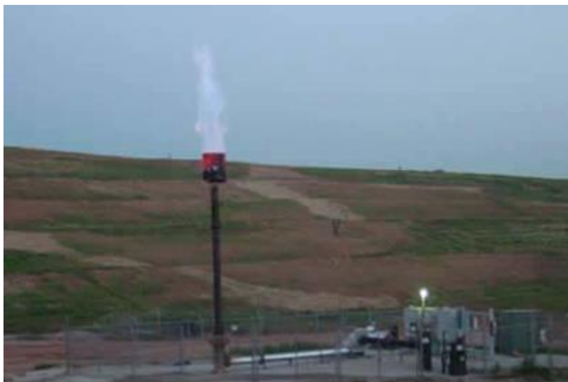
Figura 14.1 – Queima de biogás por flare em aterro sanitário para conversão de metano em gás carbônico, menos poluente.
