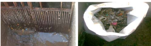
Figura 24 - Resíduos Sólidos interceptados na etapa de gradeamento do processo de tratamento de esgoto.
