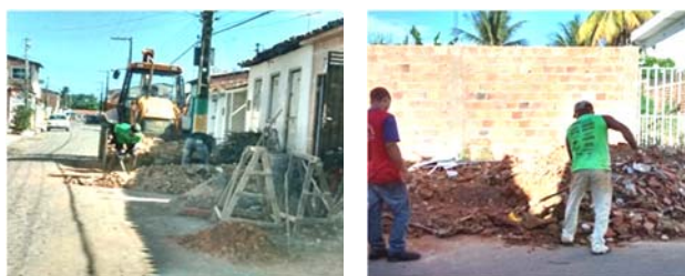
Figura 14 - Coleta de resíduos da construção civil no município de Jequiá da Praia (esquerda) e Coruripe (direita).
