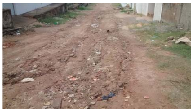
Figura 16 - Reutilização dos resíduos da construção civil em rua no município de Barra de São Miguel.
