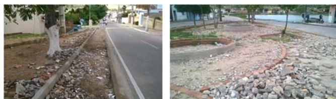
Figura 14 - Reutilização dos resíduos da construção civil em rua no município de São José da Tapera.
